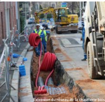
Extension du réseau de la chaufferie bois
