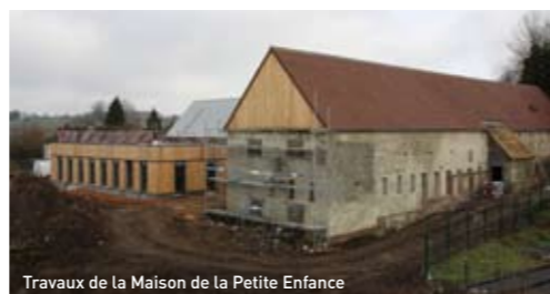
Travaux de la Maison de la Petite Enfance
