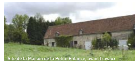
Site de la Maison de la Petite Enfance, avant travaux
