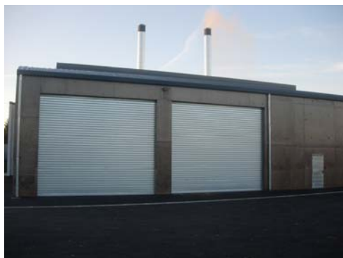
La chaufferie et son silo de stockage
